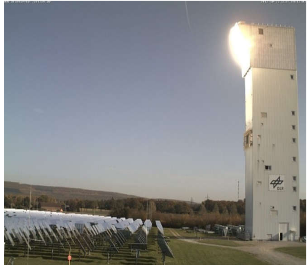
DLR Solarturm, Jülich
